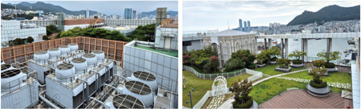
&lt;그림 2&gt; 기존 냉각탑 적용건물 옥상(좌측) 및 수열 냉난방 도입건물 옥상(우측)
